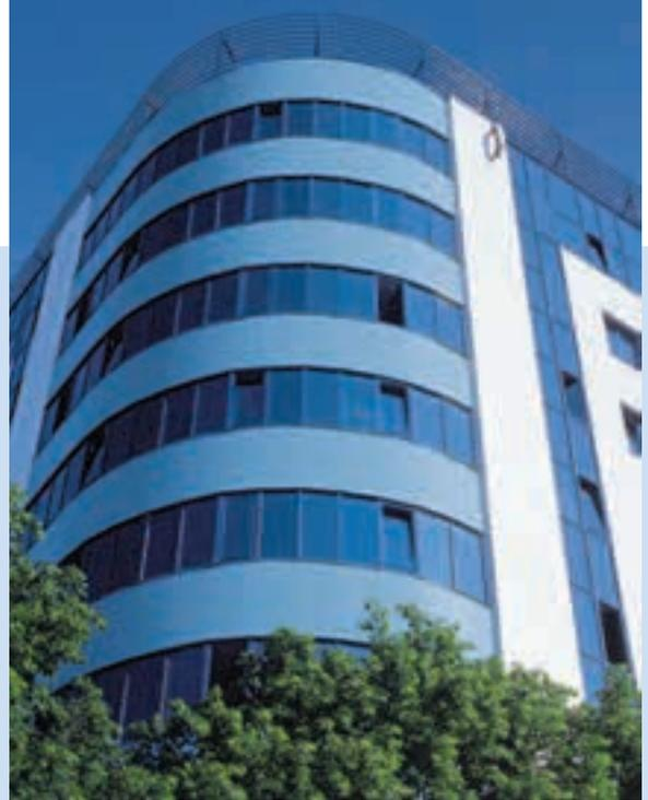
EL sistema de fachada Hunter Douglas tipo 150F/200F está compuesto por paneles de 150 ó 200 mm de ancho, fabricados a base de tecnología de perfilado continuo y con junta a tope. Los paneles están prelacados en banda continua con el acabado Luxacote® resistente a rayos UV y arañazos.
