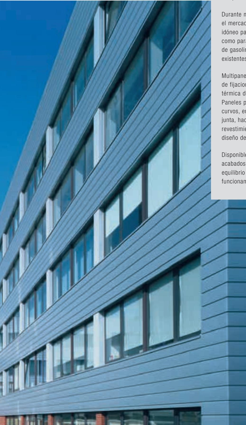
El sistema Multipanel de Fachada (MPF) de Hunter Douglas es una solución económica para los revestimientos de fachada, sin complicados métodos de ejecución.
