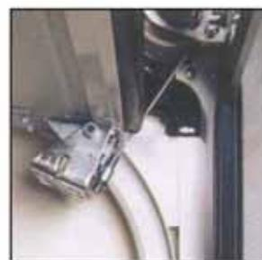
Dispositivos de Seguridad por rotura de cables.
